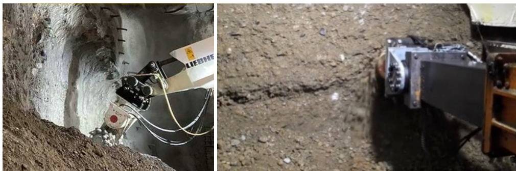
Fräsmaschinen © SF/Marco Borelli
